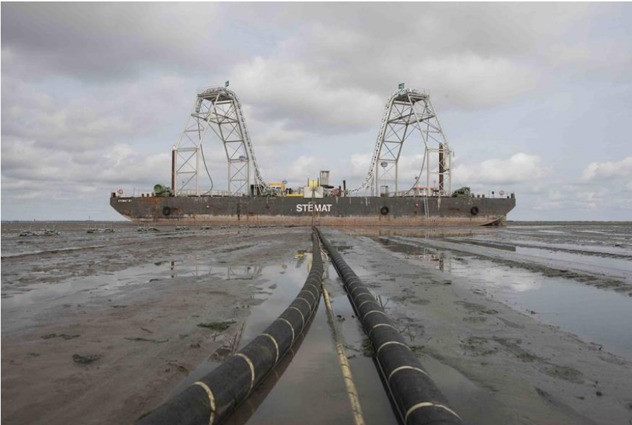
Abbildung 12: Von der 10-Meter-Tiefenlinie auf See Richtung Strand wurde das Kabel mithilfe der „Nostag“ verlegt (Quelle: ABB/TenneT)
