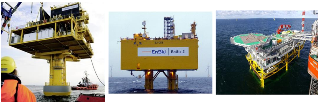
Abbildung 2: OSS von Baltic 1, Baltic 2 (Quelle jeweils EnBW) und Wiking (Quelle Kühnpro offshore)
