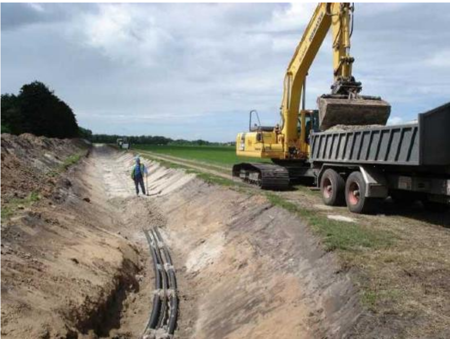
Abbildung 13: Installation des Landkabels von BorWin1 im Sommer 2008. Quelle: ABB
