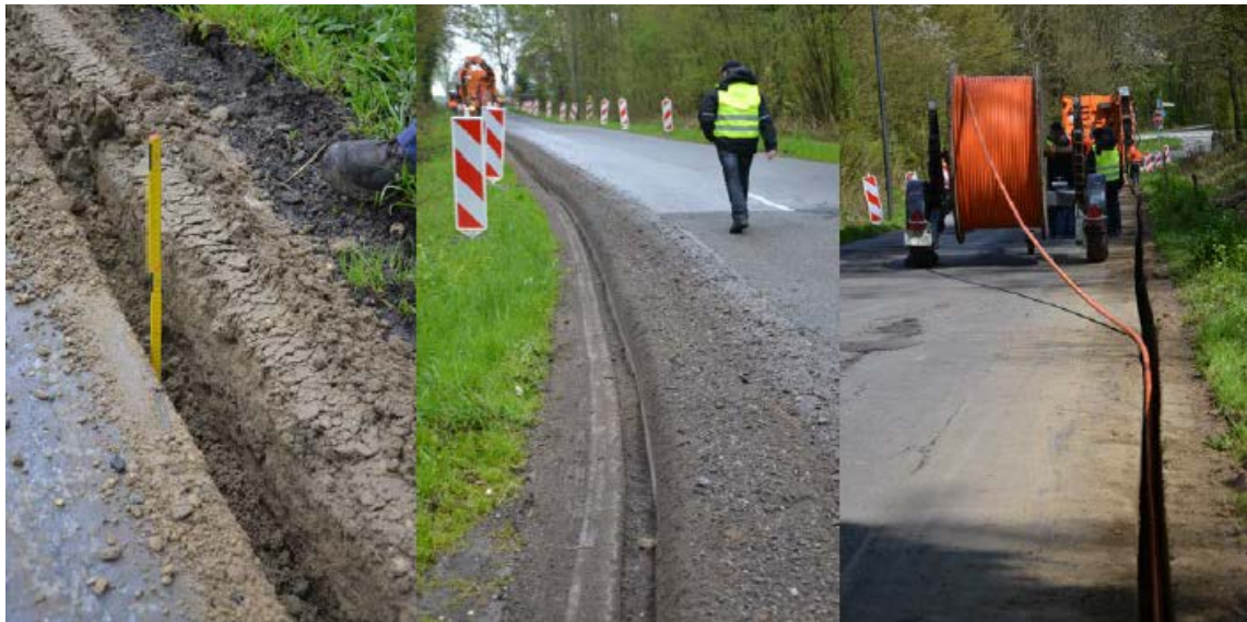
Abbildung 3-14: Mini-Trenching und die Verlegung von Kabel bzw. Leerrohren
